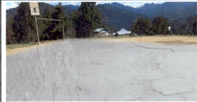
Foto 1: Patio donde se reparara la losa del patio existente
